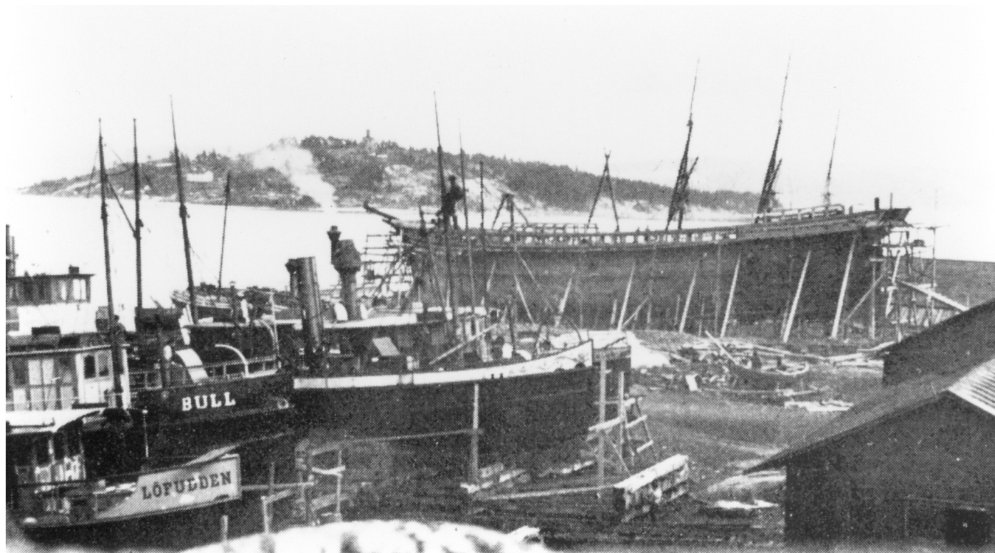
Skonerten Sylphide under byggnad på Vindskärs varv 1885
