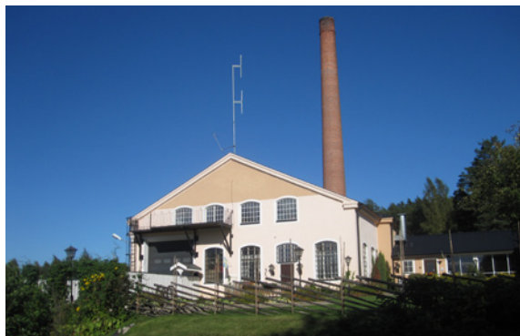
I Karlsvik finns pannhus och skorsten bevarade.
